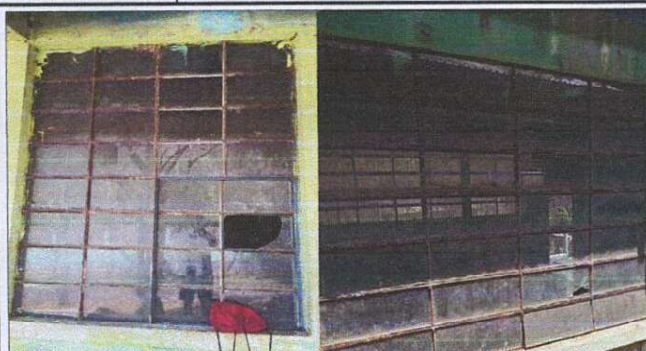
SUSTITUCIÓN DE VENTANAS DE METAL Y VUDRIO POR VENTANAS PVC EN AULA Y COCINA
