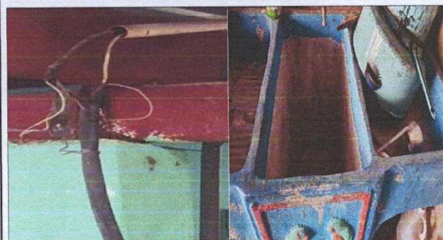
SUSTITUCION DE TUBO DUCTO Y CABLEADO DE ACOMETIDA. SUSTITUCION DE PILA PREFABRICADA DE DOS LAVADEROS
